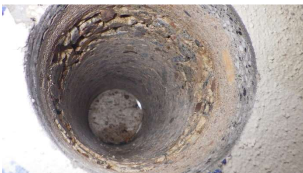
Foto 6.6.3 Detailní pohled do ostění po vyjmutí provedeného jádrového vývrtu s označením V-06
