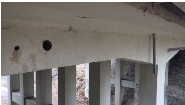
Foto 6.2.1 Pohled na provedené místo jádrového vývrtu Ø 75 mm s označením V-02 odebraného z bočního líce 6. trámu (krajní pravý trám) zleva v poli 1
