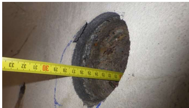
Foto 6.2.2 Měření celkové hloubky provedeného jádrového vývrtu Ø 75 mm s označením V-02 odebraného z bočního líce 6. trámu (krajní pravý trám) zleva v poli 1
