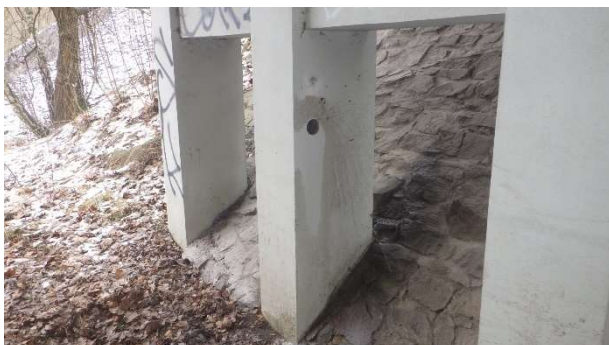
Foto 6.5.1 Pohled na provedené místo jádrového vývrtu Ø75 mm s označením V-05 odebraného z boční stěny 2. sloupu pilíře P3 zprava
