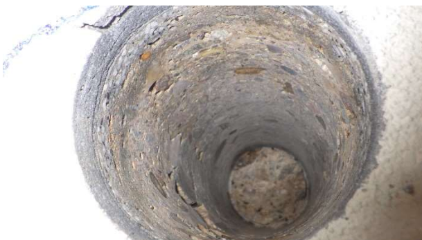
Foto 6.2.3 Detailní pohled do ostění po vyjmutí provedeného jádrového vývrtu s označením V-02
