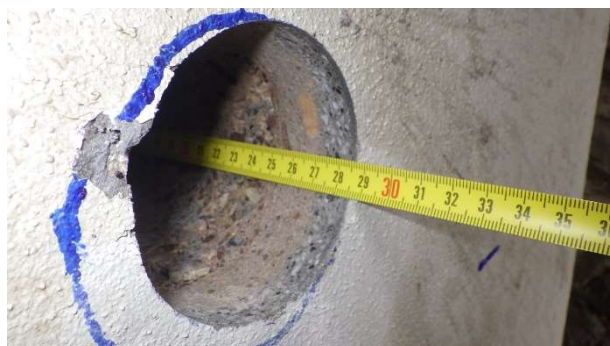
Foto 6.6.2 Měření celkové hloubky provedeného jádrového vývrtu Ø75 mm s označením V-06 odebraného z boční stěny 5. sloupu pilíře P3 zprava
