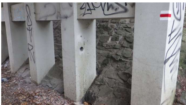
Foto 6.6.1 Pohled na provedené místo jádrového vývrtu Ø75 mm s označením V-06 odebraného z boční stěny 5. sloupu pilíře P3 zprava
