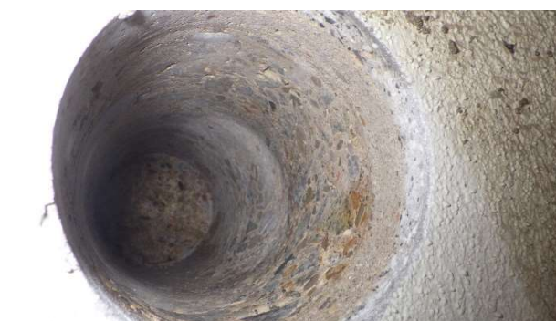
Foto 6.5.3 Detailní pohled do ostění po vyjmutí provedeného jádrového vývrtu s označením V-05
